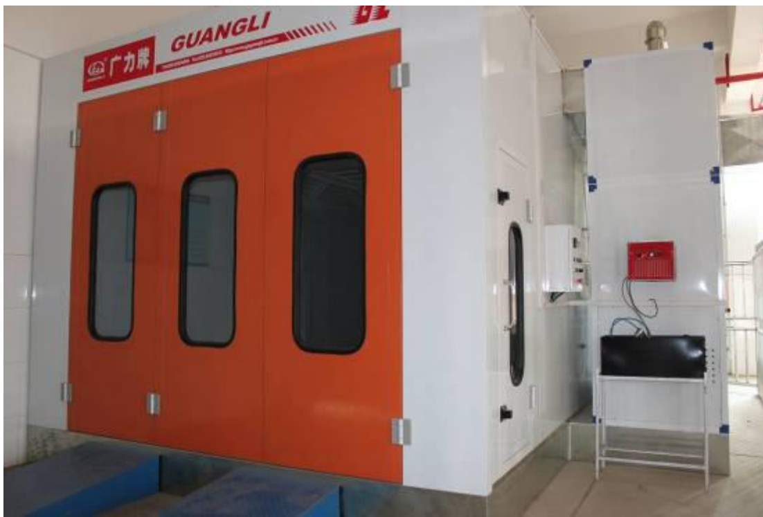
汽修实训工场（三）
